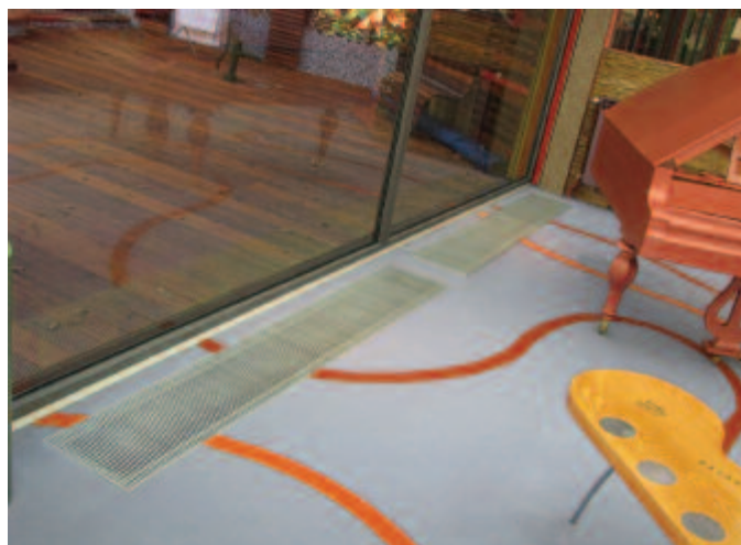
Slika 1. Podni konvektori ugrađeni u prostor
