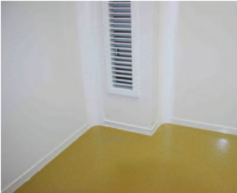
Slika 2. Detalj izvedbe cleanroom panela
