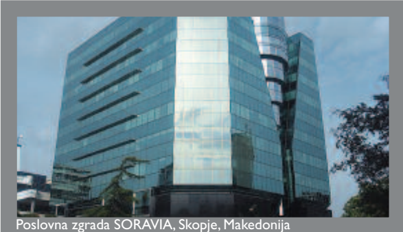
Poslovna zgrada SORAVIA, Skopje, Makedonija
